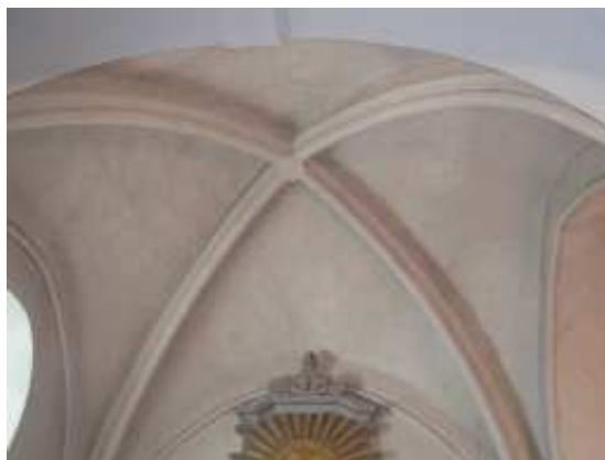
ill. 8 : Voûte de la chapelle nord.
