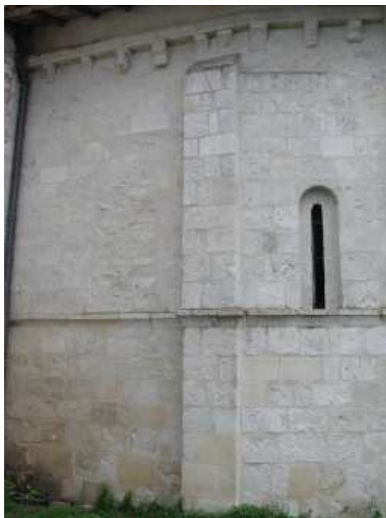
ill. 2 : Baie du XVII e siècle, murée.
