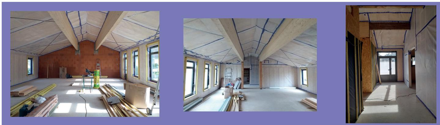
Le gros œuvre et les travaux de charpente et de couverture sont terminés. Les entreprises vont désormais travailler à l'intérieur du futur bâtiment. Le système de chauffage et de ventilation sera installé dans les prochaines semaines, suivant l'avancement du plâtrier. Côté cour de l'école maternelle, il reste à installer le préau qui sera supporté par quatre piliers bois.
