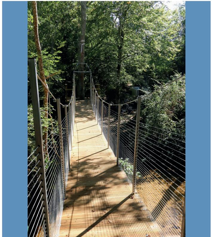
L'ouvrage respecte l'environnement : il s'agissait de créer une passerelle de type "pont suspendu", afin de n'intervenir en aucune manière sur le cours d'eau tout en respectant au maximum l'intégrité des arbres "supports", et d'avoir un impact environnemental quasiment nul.
